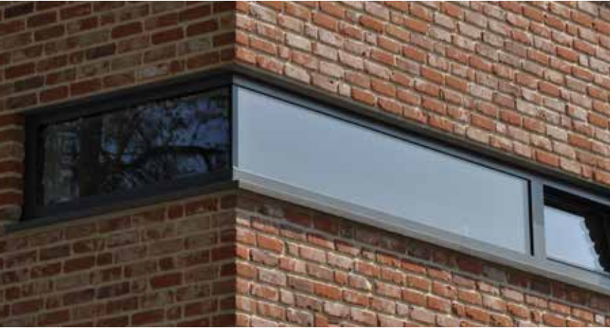
Innen Holz in dunkler Ebenholz-Oberfläche ... ... und außen Aluminium in modernem Grau.
