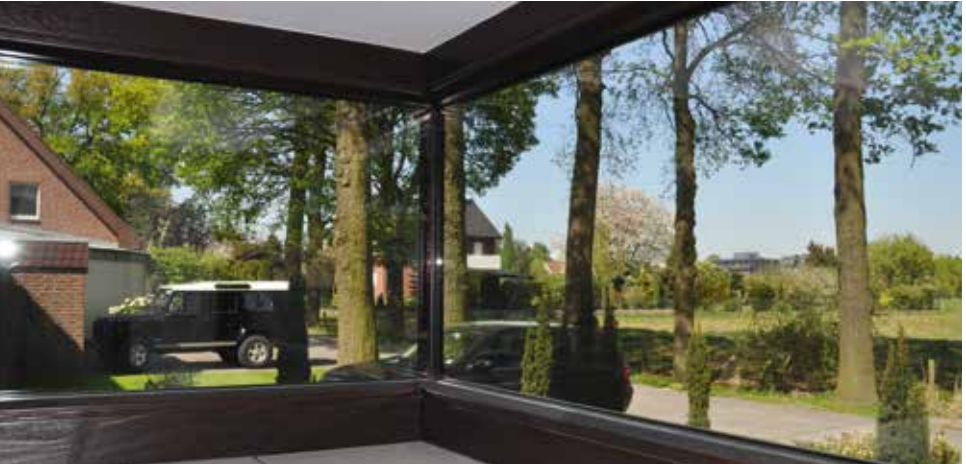
Innen Holz in dunkler Ebenholz-Oberfläche ... ... und außen Aluminium in modernem Grau.
